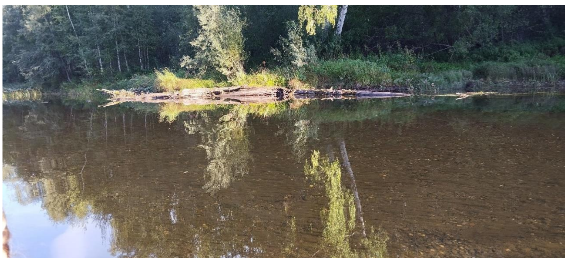
Фото № 39-40. Разрушенные отбойники у высоких берегов. Их когда-то построили спецпереселенцы – жители тех самых посёлков – для предотвращения образования заторов бревен при молевом сплаве.
